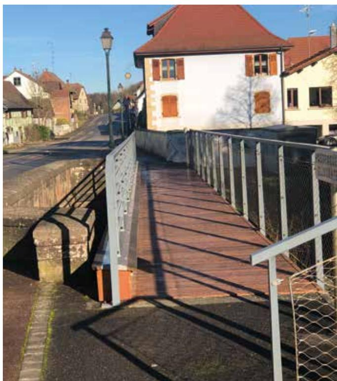
Le bois de la passerelle sur le Thalbach, à côté du pont rue principale était antidérapant, mais il a mal vieilli.
